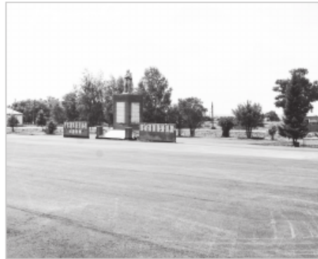
Уложено асфальтовое покрытие.
